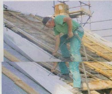
La pulizia dei fori mediante aspiratore per l'eliminazione dei detriti e delle polveri prima dell'iniezione della resina.
