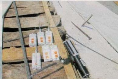
zione è stata l'esecuzione delle perforazioni nella muratura per l'inserimento delle barre di cucitura e rinforzo. Per evitare effetti di vibrazione e percussione sulle strutture murarie sono state utilizzate carotatrici con sonda diamantata, con
