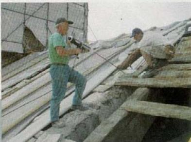
L'estrusione della resina con la pompa pneumatica.
