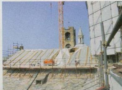
Il cantiere successivamente alla rimozione del manto di copertura in lastre di ardesia nelle falde della navata centrale.
